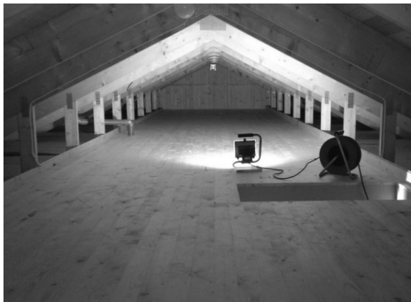
Januari 2015. Vinden isolerad och försedd med golv. Bra förrådsutrymme!
