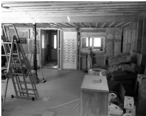
Golv och väggar isolerade, innerväggar resta och en hel del av elinstallationen är förberedd.
