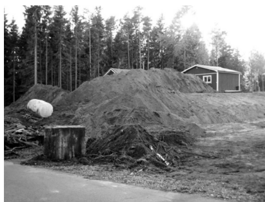
Stort markjobb, skogen nertagen, markarbeten med anläggning av P-plats och jämnning av övrig tomt inkl stubborttagning.
