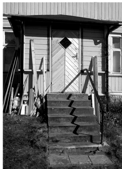
Ebert SM7VRI har just provmonterat den nya dörren på södergaveln. Nedanför trappan var det polsten med hål i så myrorna trivdes där. Vi körde bort polstenen, strödde ut Myrr och lade dit betongplattor i stället
