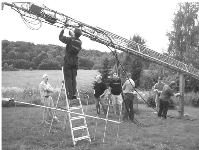
En sommarkväll var det dags för översyn och uppsmörjning av VHF-rotorerna. Magnus UGO jobbar med glada tillrop och kommentarer från oss övriga!
