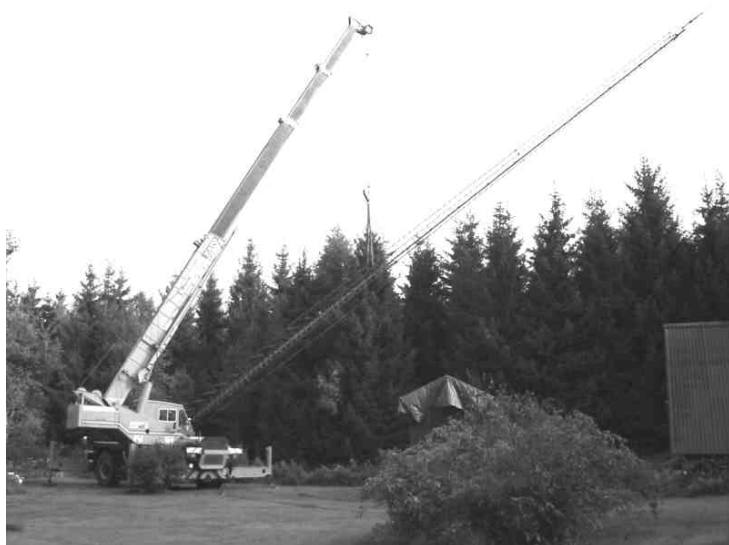
Kranbilen lyfter lätt masten i ett stycke
