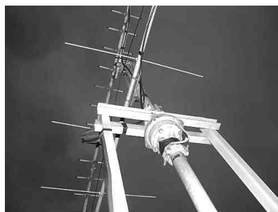
Här syns hur ramen är fastmonterad ovanför rotorhuset.
