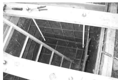
En grop med bultar och armeringskorg, färdigt för ingjutning.
