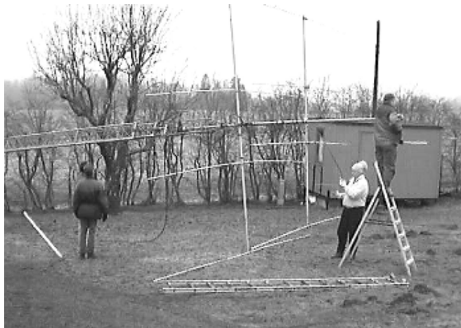
Nedtagning av 10-15m masten. Det gråkalla vädret avskräckte inte.
